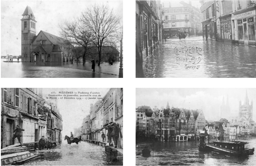
Fig. 2. Les inondations de 1919 : crue de la Bruche à Strasbourg, 25 décembre 1919 (en haut à gauche) ; crue de la Moselle à Épinal, 24 décembre 1919 (en haut à droite) ; crue de la Meuse à Mézières, janvier 1920 (en bas à gauche) ; crue du Rhin à Cologne (en bas à droite) [Collection privée]
