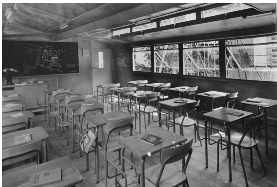
Fig. 1 : Jacques Hitier décorateur et Félix Brunau architecte, prototype d'école préfabriquée installée devant le Grand Palais de Paris, fabricants Usine Million-Guiet-Tubauto (MGT), vue de la salle de classe, Salon 1954. Paris, Bibliothèque du Musée des arts décoratifs/Fonds de la Société des Artistes Décorateurs, cote SAD 329. Photographie : © Jean Collas.
